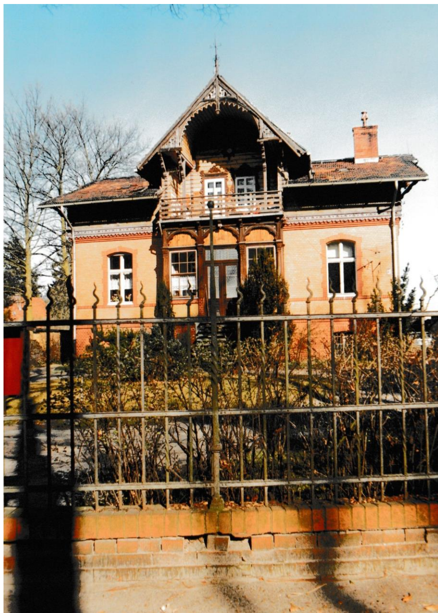
An den ersten auf ehemals Hankelschem Grund und Boden erbauten Landhäusern finden sich noch heute reizvolle architektonische Details (Lindenallee 8)
