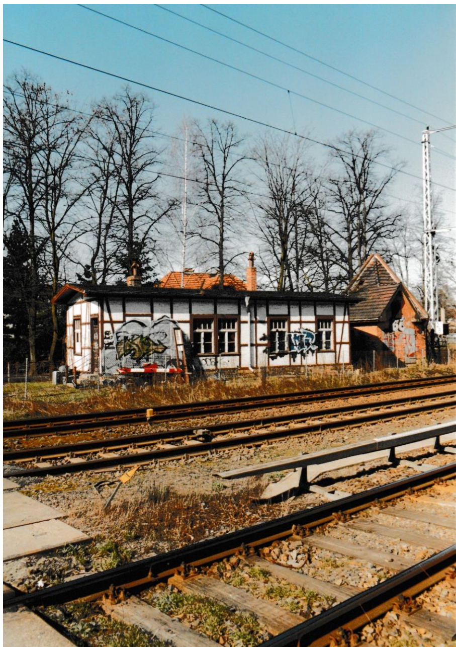
Reste der alten Stationsgebäude westlich des S-Bahnhofs
